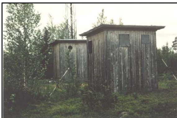
BRATTÅKER - STATIONSBYGGNADERNA. EN NERLAGD TRÅDRADIOSTATION
