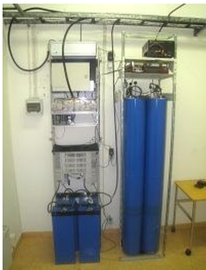
6 m duplexfilter och repeater till höger.
